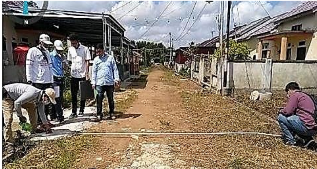
Gambar I-45 Contoh Pelaksanaan Pengukuran Awal Bersama Untuk Pembangunan Jalan Lingkungan
