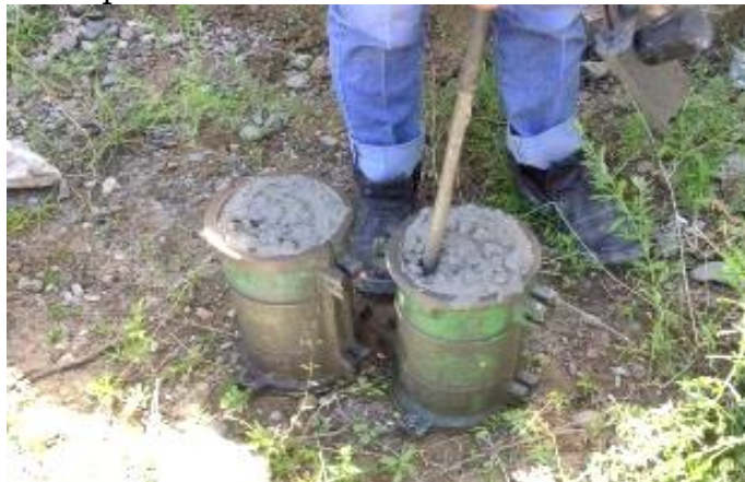
Gambar II-28 Contoh Pengambilan Sampling Benda Uji Silinder Beton
