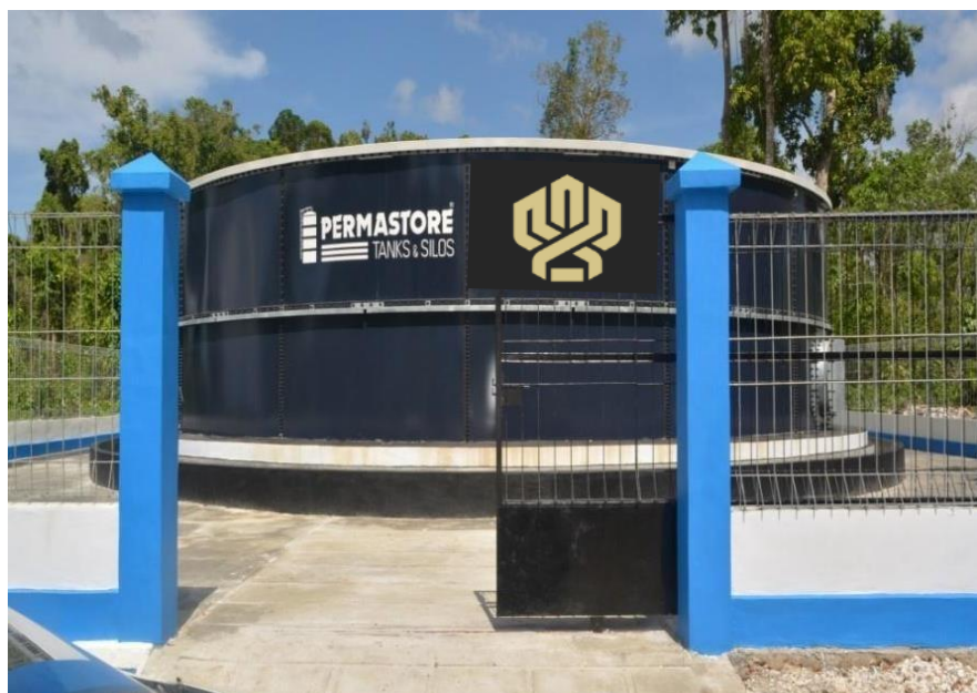
Gambar I-22 Contoh Reservoir Permukaan (Ground Reservoir) dengan Material Glassteel
