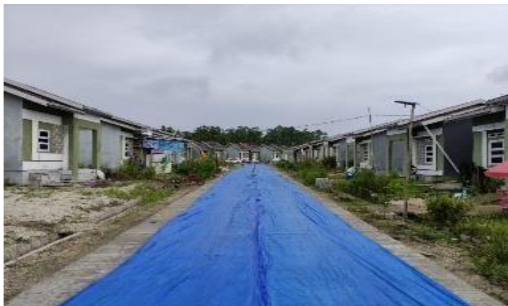
Gambar III-30 Contoh Pemasangan Plastik Fondasi
