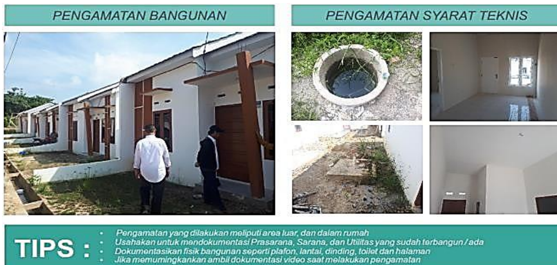
Gambar III-19 Pengecekan Kondisi Rumah dan Kelengkapan Persyaratan Rumah Umum
