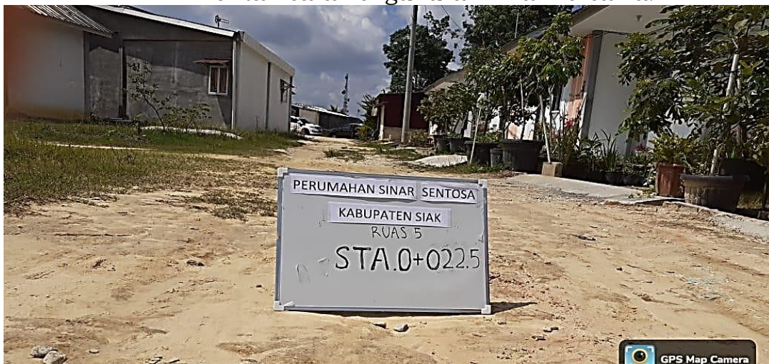
Gambar III-23 Contoh Penentuan Titik Nol Pada Lokasi Pembangunan
