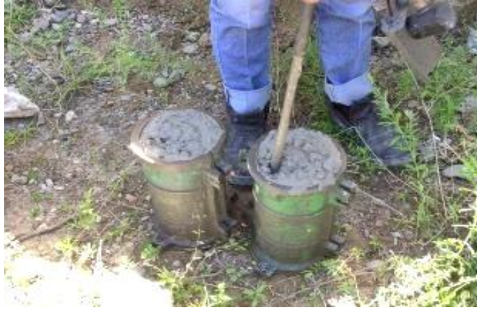
Gambar I-48 Contoh Pengambilan Sampling Benda Uji Silinder Beton
