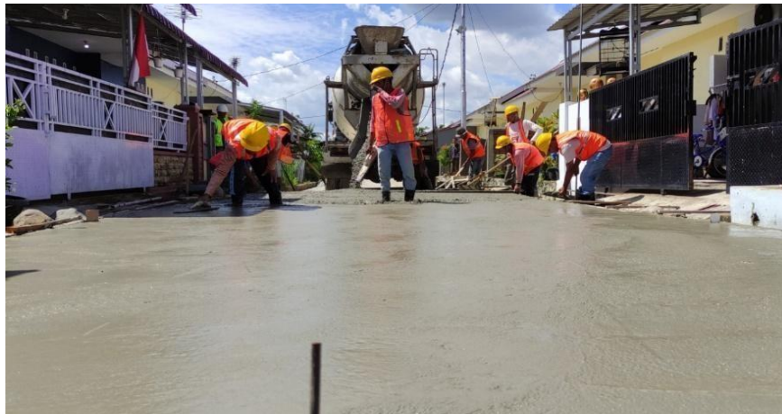
Gambar I-50 Contoh Pelaksanaan Pekerjaan Perkerasan Beton Semen
