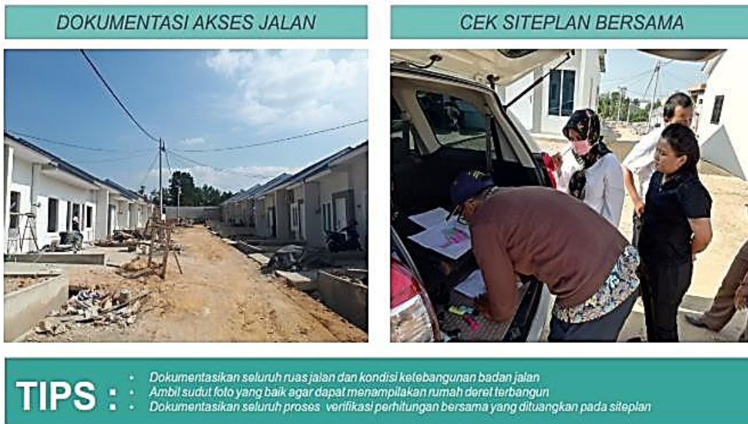
Gambar I-38 Pengecekan Rencana Tapak dan Kondisi Badan Jalan
