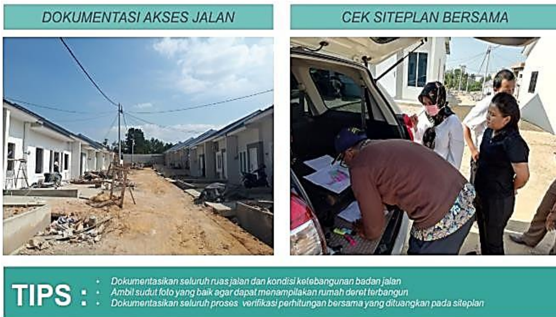
Gambar III-18 Pengecekan Rencana Tapak dan Kondisi Badan Jalan
