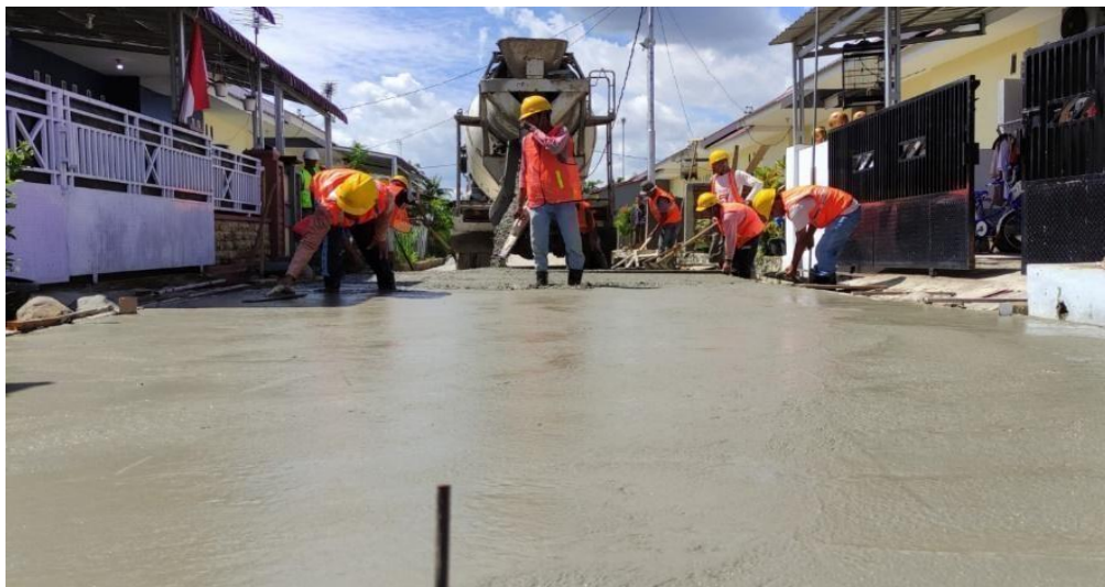
Gambar III-29 Contoh Pelaksanaan Pekerjaan Perkerasan Beton Semen
