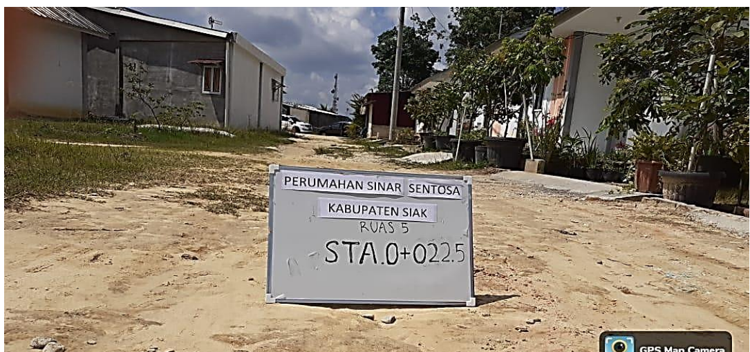
Gambar I-44 Contoh Penentuan Titik Nol Pada Lokasi Pembangunan
