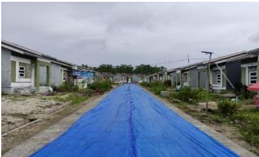
Gambar I-51 Contoh Pemasangan Plastik Fondasi
