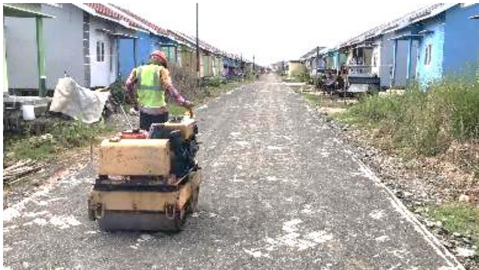
Gambar III-31 Contoh Pelaksanaan Pekerjaan Perkerasan Jalan dengan Paving Block
