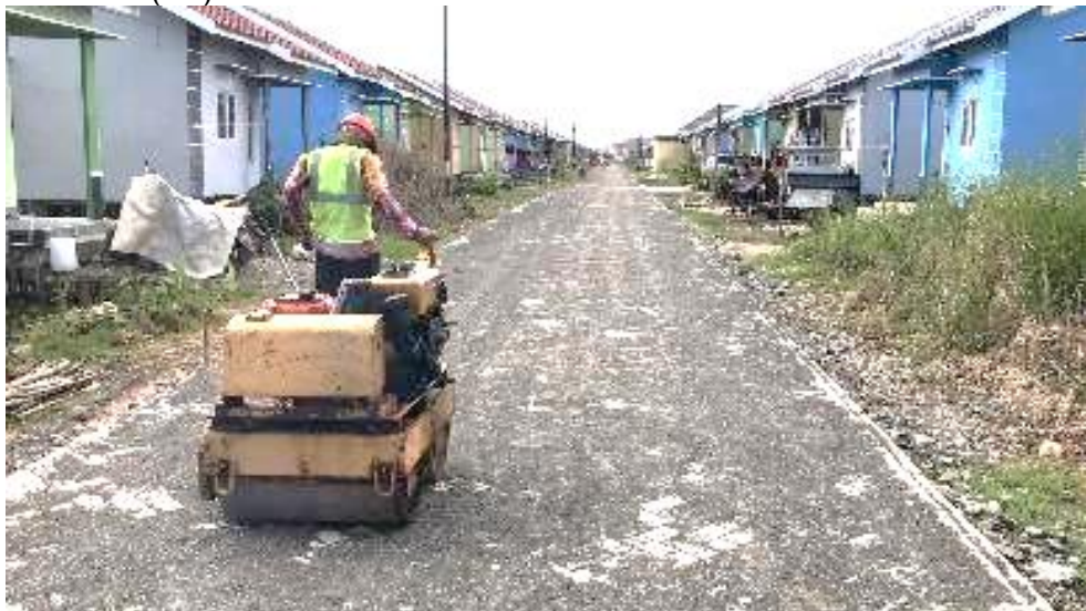
Gambar I-52 Contoh Pelaksanaan Pekerjaan Perkerasan Jalan dengan Paving block
