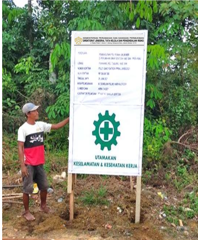
Gambar I-46 Contoh Pemasangan Papan Nama Proyek
