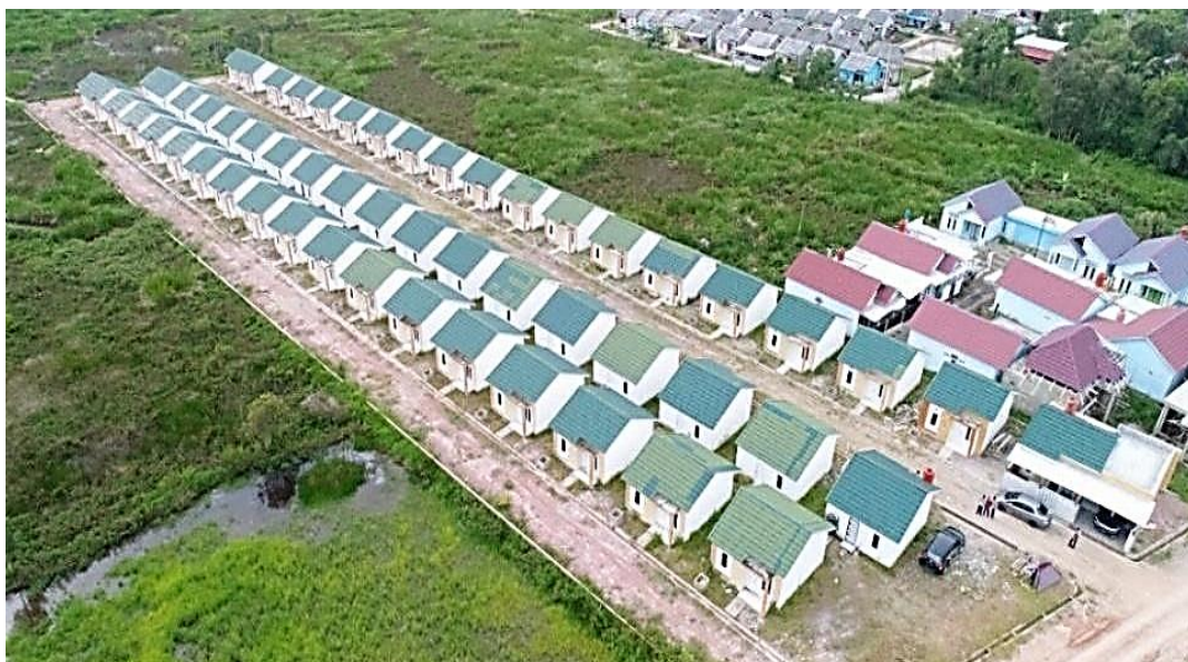
Gambar I-42 Contoh Dokumentasi Perumahan Menggunakan Drone
