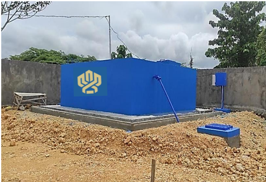
Gambar I-21 Contoh Reservoir Permukaan (Ground Reservoir) dengan Material Beton
